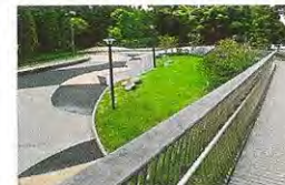
Suzhou River Park, Shanghai. Progetto di Studio BAU
